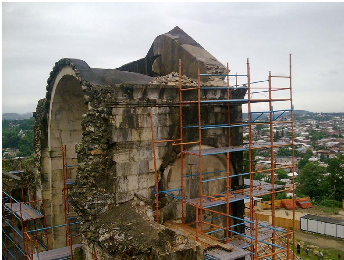
ნახ.11. დაზიანებული აღმოსავლეთ კედელი
