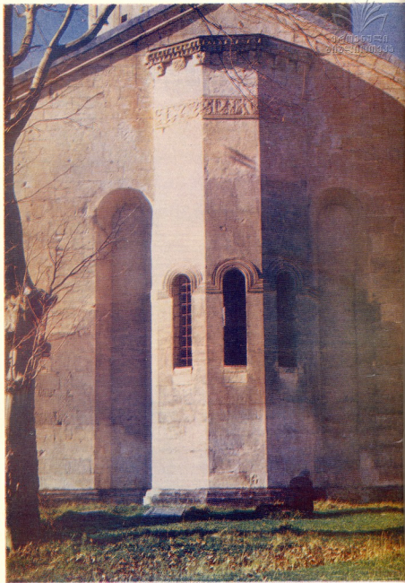
მარტვილი. ზედი აღმოსავლეთით. ვ. ცინცაძის ფოტო. Martvili. Вид на восток. Фото В. Цинцадзе.
