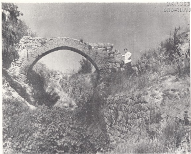
ახალაღმშენილი წყალსადენის თაღ- ვანა ხიდი. სადაც წუობაში ჩატანბუ- ლია წყალსადენის ჩაკირული მილები.
