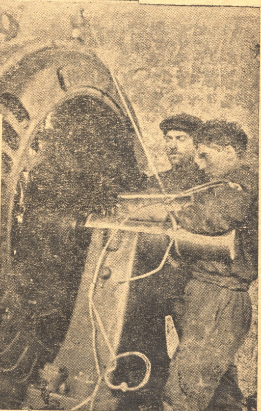
მშენი —საჭირო რკინის გზის მშენებლობაზე სამონტაჟო სამუშაოები (სადგ. ტყვარჩელი); ტყვარჩელში—150 ცხ. ძალიან დიზელის დადგმა ელსადგურზე. დადგმას აწარმოებენ დამკვერელები აშხ. სლესკინი და ფასნავტი. მშენი —ტყვარჩელის ელსადგურის შენობა. ამ სადგურს ძალისხმევა 900 კილოვატს უდრის; გენერატორების დადგმა ტყვარჩელის ელსადგურზე. მუშაობას აწარმოებენ დამკვერელები აშხ. სოკოლოვი და გრუშაძევი.
