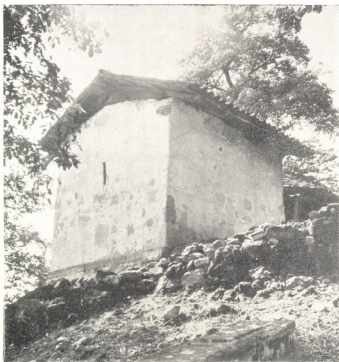
ჩიხა. საერთო ხედი
