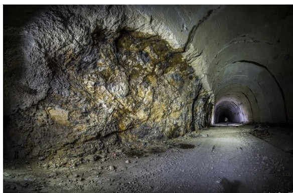
Рис 3.4 Состояние водонапорного туннеля
