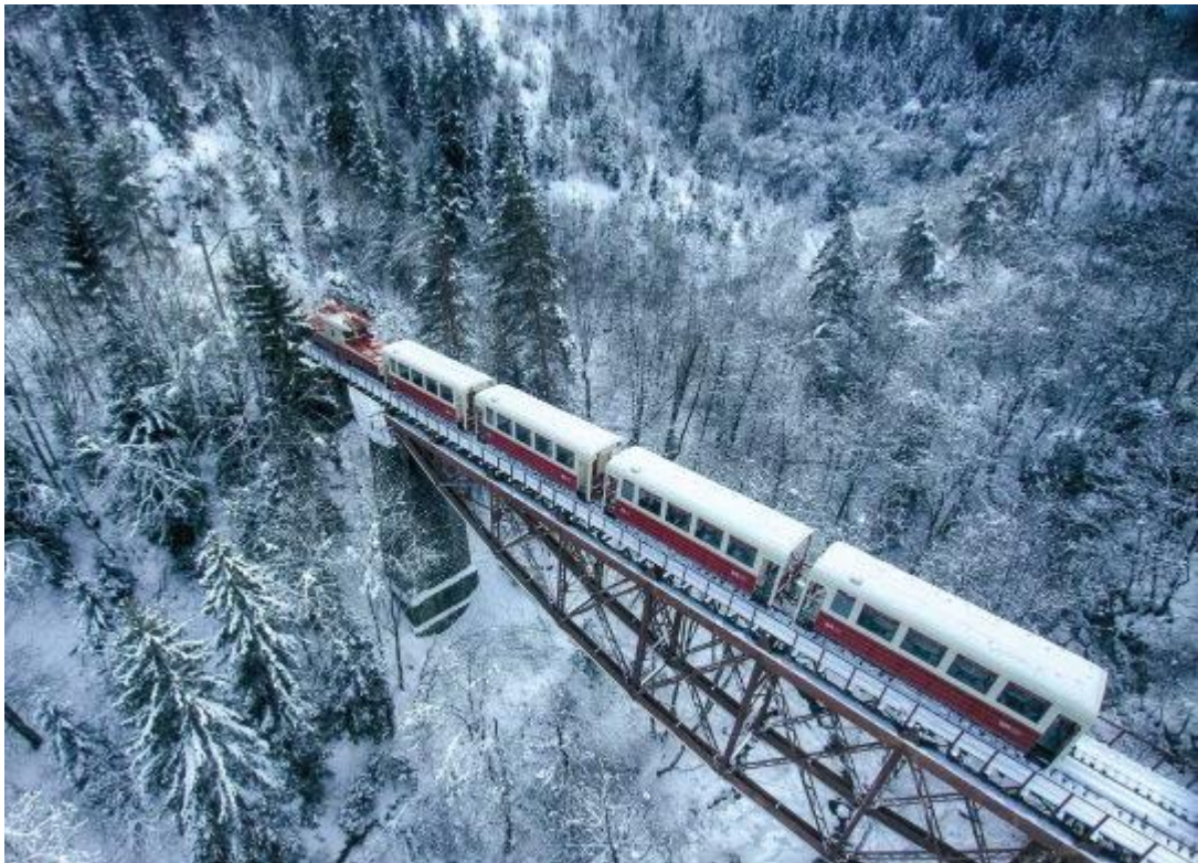
ნახ.11. ხიდი მდინარე ცემისწყალზე
