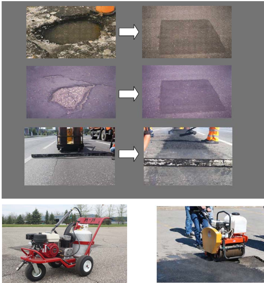
ნახ. 3 ასფალტბეტონის საფარის ორმოული შეკეთების პროცესი ინფრაწითელი გამოსხივების გამოყენებით
