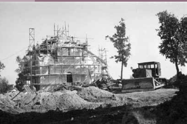
Начало реставрационных работ в Андрониковом монастыре
