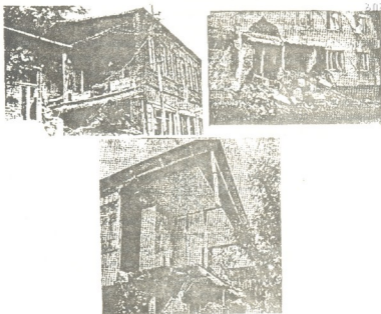
Рис.2. Здания, пострадавшие от землетрясений
