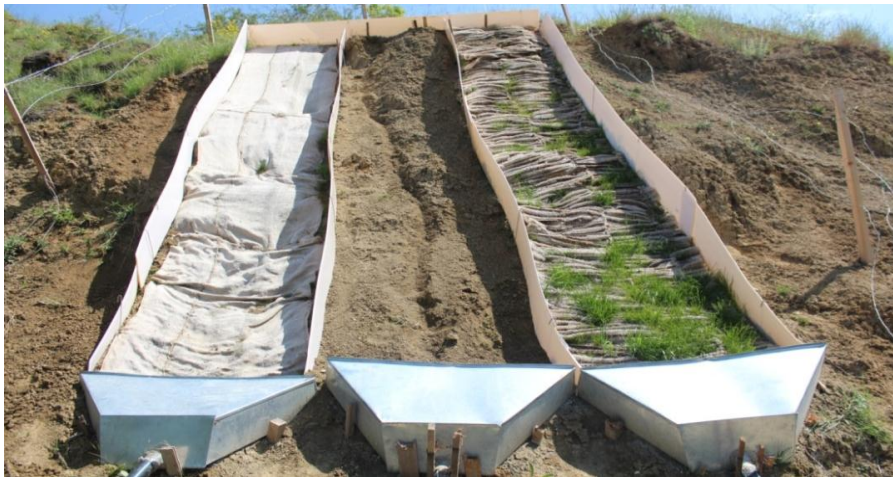
Фото 2. Вид исследовательского полигона через 104 дня после монтажа
