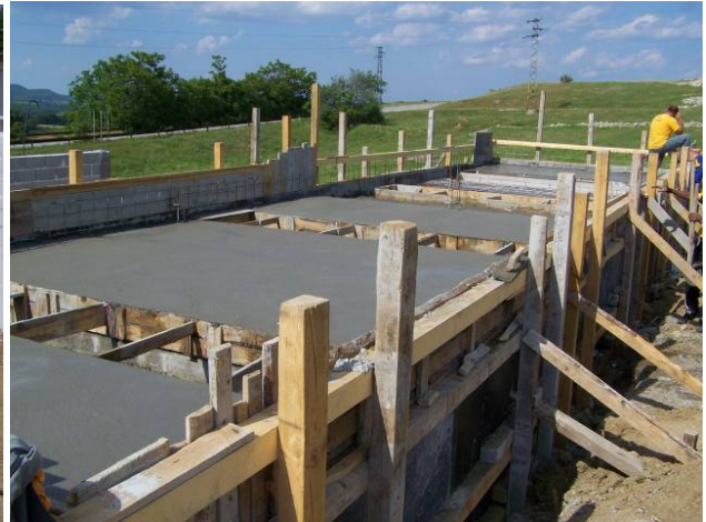
Фото 2. Поле для высушки осадка в процессе строительства (ОСОВ - с. Лясковец)
