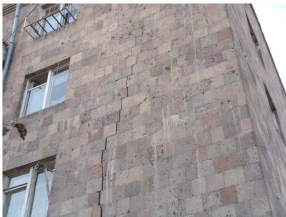
Рис.1 Трещины в каменных стенах (ул. Шинарарнери 15)
