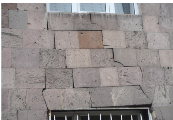
Рис.2. Трещины в каменных стенах (ул. Демирчяна 17)
