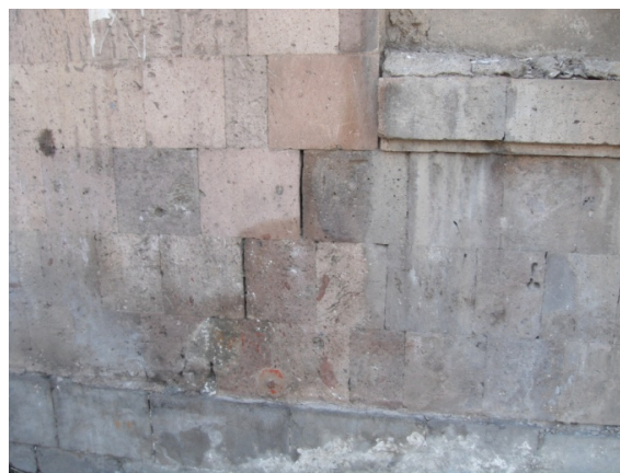
Рис.1 Трещины в каменных стенах (ул. Шинарарнери 15)
