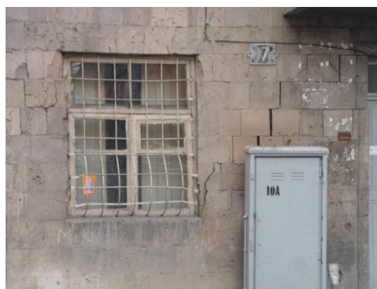
Рис.2. Трещины в каменных стенах (ул. Демирчяна 17)
