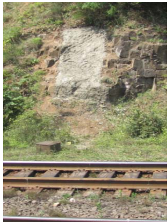
ფოტო 10. დაბეტონებული ზედაპირი რკინიგზის მიმდებარე საკვლევე უბანზე
