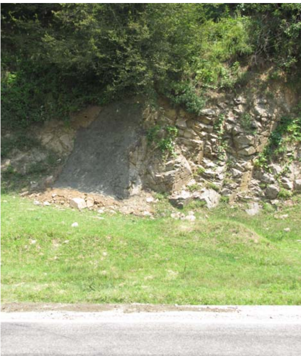
ფოტო 9. დაბეტონებული ზედაპირი საავტომობილო გზის საკვლევე უბანზე
