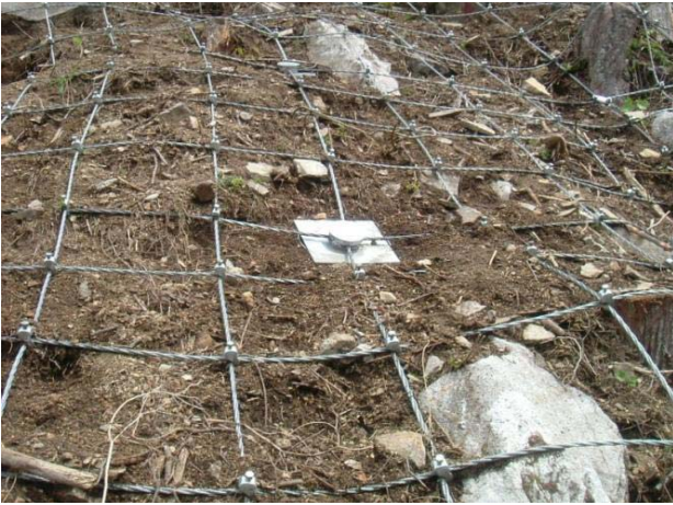
ფოტო 2. ეროზირებულ ფერდობზე ანკერების მონტაჟი იტალიის მაგალითზე
