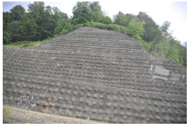
ფოტო 1. ეროზირებული ფერდობის გამაგრება ტორკრეტბეტონის მეთოდით იტალიის მაგალითზე
