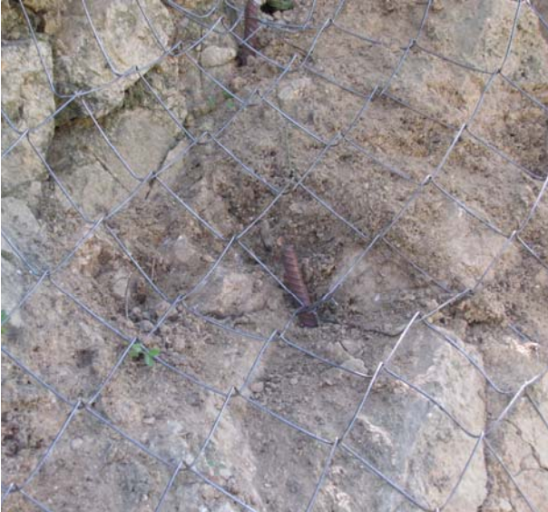
ფოტო 7. ბეტონქვეშა ლითონის ბადის ანკერებით გამაგრება საავტომობილო გზის საკვლევე უბანზე
