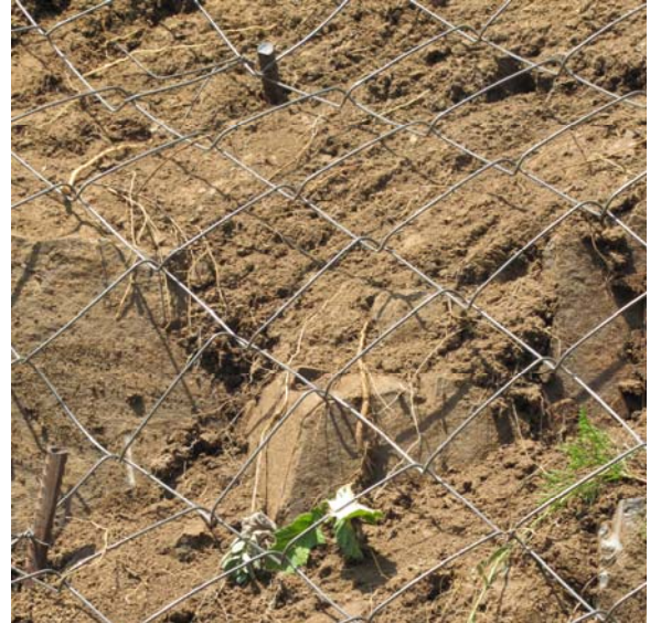
ფოტო 8. ბეტონქვეშა ლითონის ბადის ანკერებით გამაგრება რკინიგზის მიმდებარე საკვლევე უბანზე
