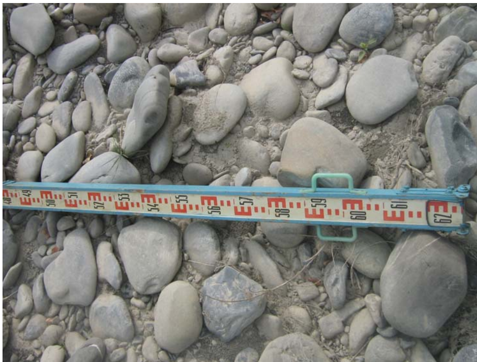
Фото 4. Поверхность русла реки на участке прилегающем к трубо-мосту.
