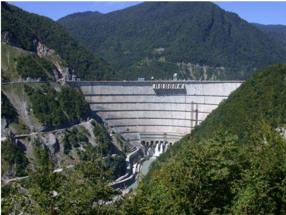
Рис. 1. Общий вид Ингурской плотины с нижнего бьефа
