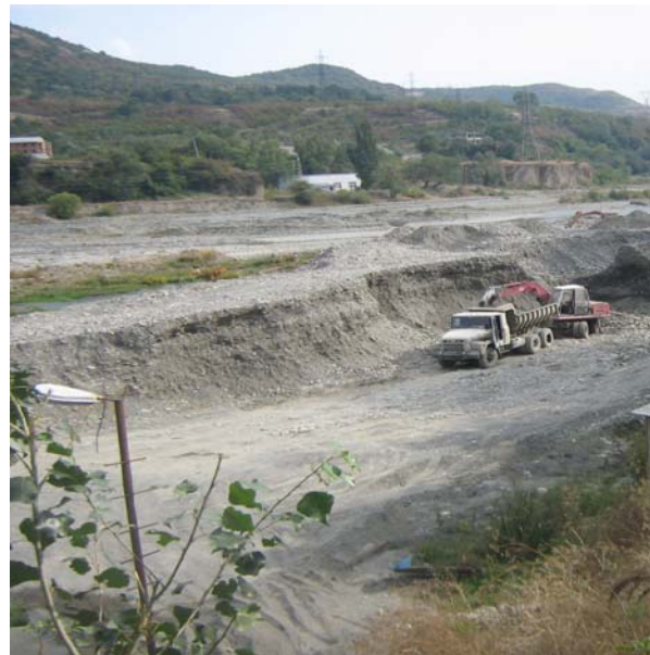
Фото 3. Интенсивный вывоз твердых наносов в русле реки Арагви близ с. Натахтари.
