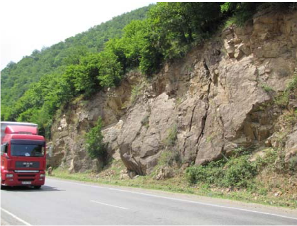
ფოტო 3. რიკოთის უღელტეხილზე, სოფ. უბისასთან
