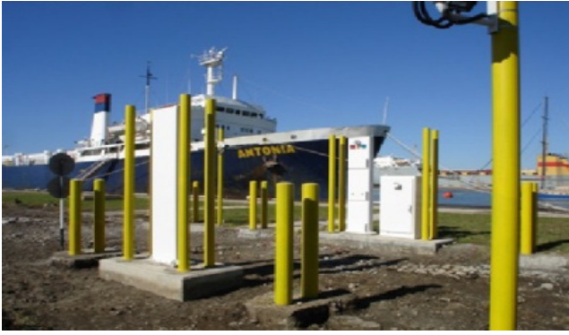
ნახ.5. ფოთის პორტის სარკინიგზო შესასვლელში (ა) და ფოთის საზღვაო პორტში დამონტაჟებული რადიაციული დეტექტორები (ბ)
