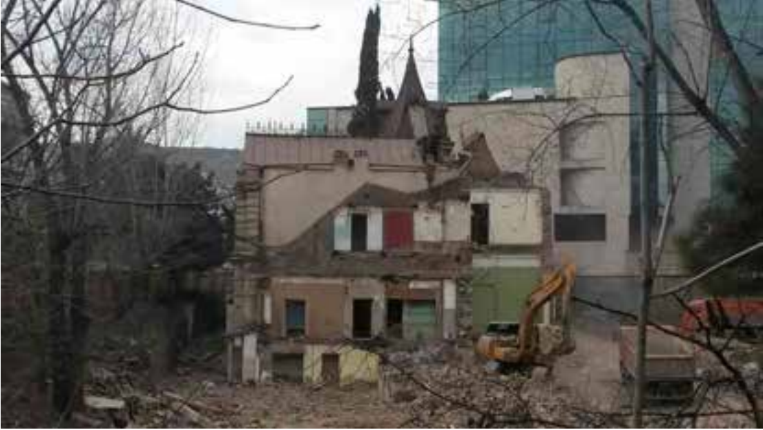
6. აღმოსავლეთი ფასადი დემონტაჟის შემდგომ After deconstruction, Eastern facade
