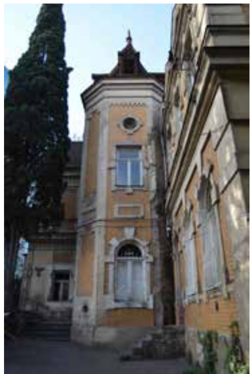
5. სამხრეთი ფასადის ნაწილი დემონტაჟამდე Before deconstruction, part of the Southern facade
