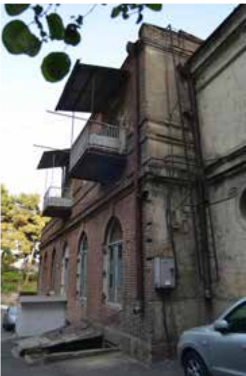
4. ჩრდილოეთი ფასადი დემონტაჟამდე Before deconstruction, Northern facade
