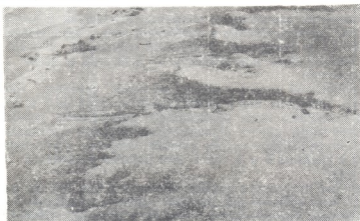
Рис. 2. Промоины в теле бара
