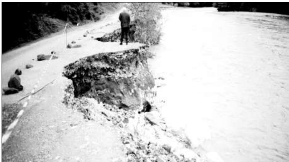
სურ. 1. ცაგერი – ლენტეხის მონაკვეთზე საავტომობილო გზის მდგომარეობა მდ. ცხენისწყლის მარჯვენა ნაპირის მხრიდან, ზედა დინებაში მარჯვენა შენაკადზე (ბაბილი) მძავრი დვარცოფის გავლის შემდეგ. (გ. ხერხეულიძე)
