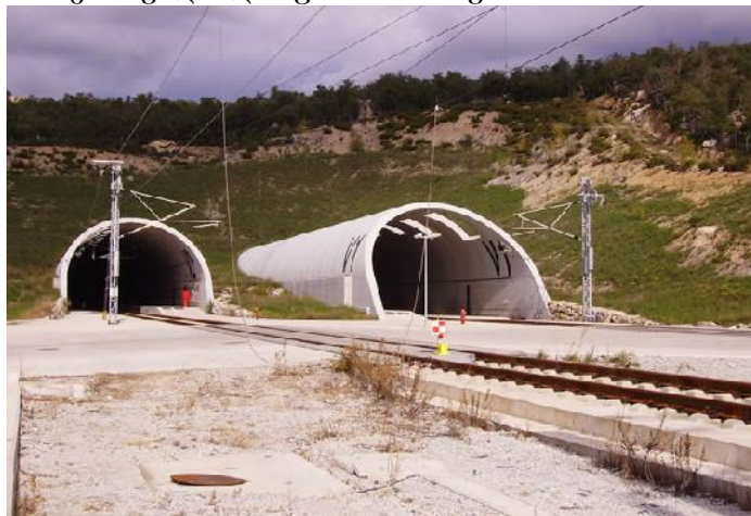
ნახ.2. გვირაბის პორტალების თანამედროვე კონსტრუქცია
