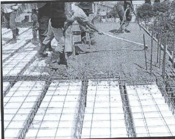
სურ. 1 მრავალსართულიან საცხოვრებელ სახლზე სართულშუა გადახურვის მოწყობის დადამასრულებელი ეტაპი - ზედა რკინაბეტონის მოწყობის სამუშაოები
