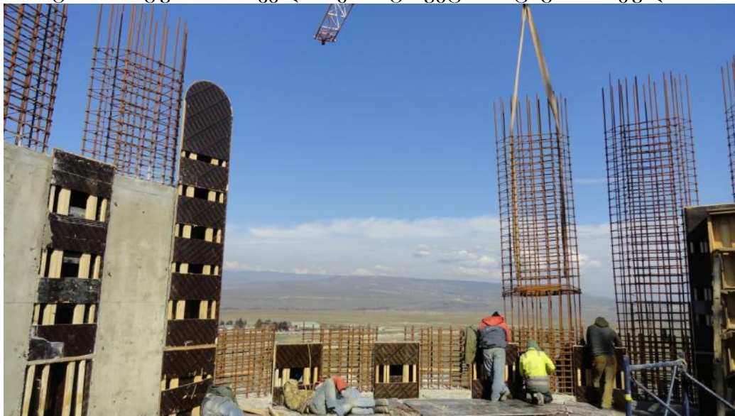
ნახ.1. კედლის არმატურის კარკასების მოწყობა
