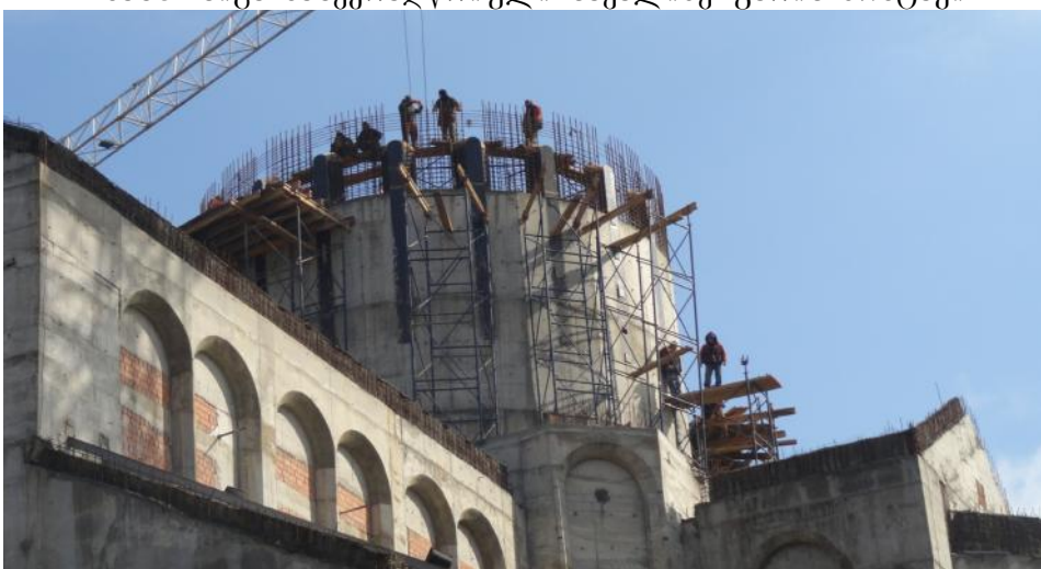
ნახ.4. დაბეტონებული წრიული რკინაბეტონის კედელი სარკმლებით
