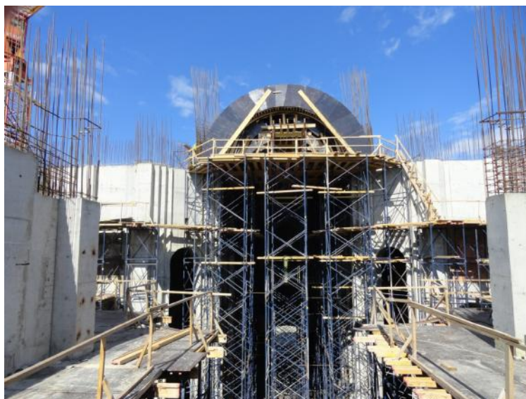
ნახ.3. გუმბათ-თაღოვანი კონსტრუქციების აგება ძალოვანი ხარაჩოებით
