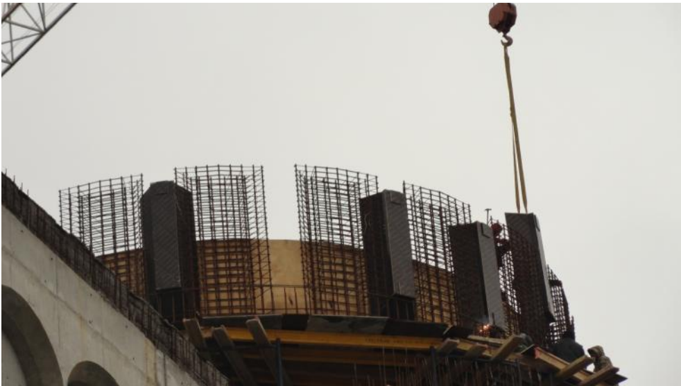
ნახ.2 არმატურის კარკასებს შორის სარკმლის ყალიბების მონტაჟი
