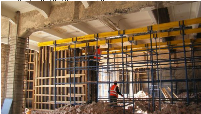
ნახ.1. ძალოვანი ხარაჩოების გამოყენება გადახურვის ელემენტების საყრდენად
