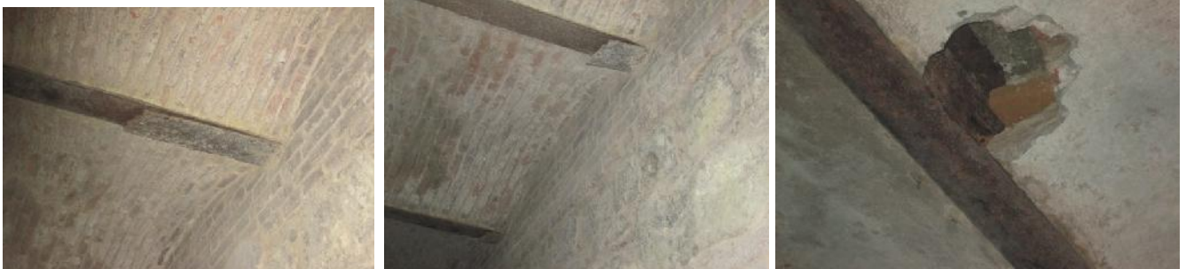
სურათები: 11, 12 და 13. ქ. თბილისში არსებული №1-ლი ღვინის ქარხნის სარდაფის გადახურვის კონსტრუქციები. სურათებზე ნათლად ჩანს კოროზირებული ლითონის ელემენტების მდგომარეობა (ძლიერ კოროზირებულია ლითონის ორტესები ელემენტები).
