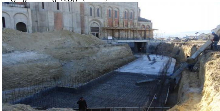
ნახ.1. რკინაბეტონის გვირაბის საძირკვლის ფილის მოწყობა
