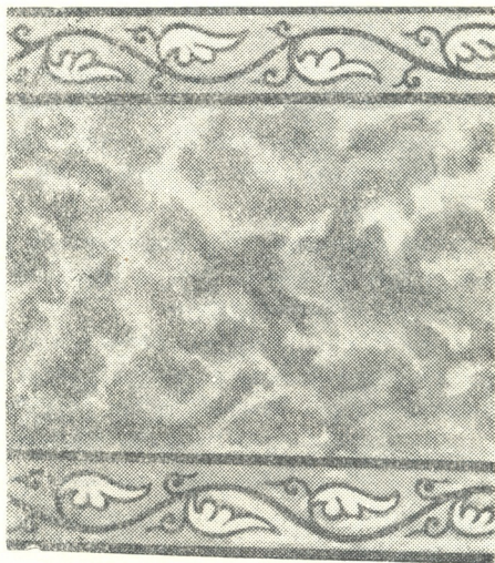
სურ. 2. არტიკის ტუფის ანგობირებული და მოჭიქურებული ფილები ზომით 60 \times 35 \times 5 სმ
