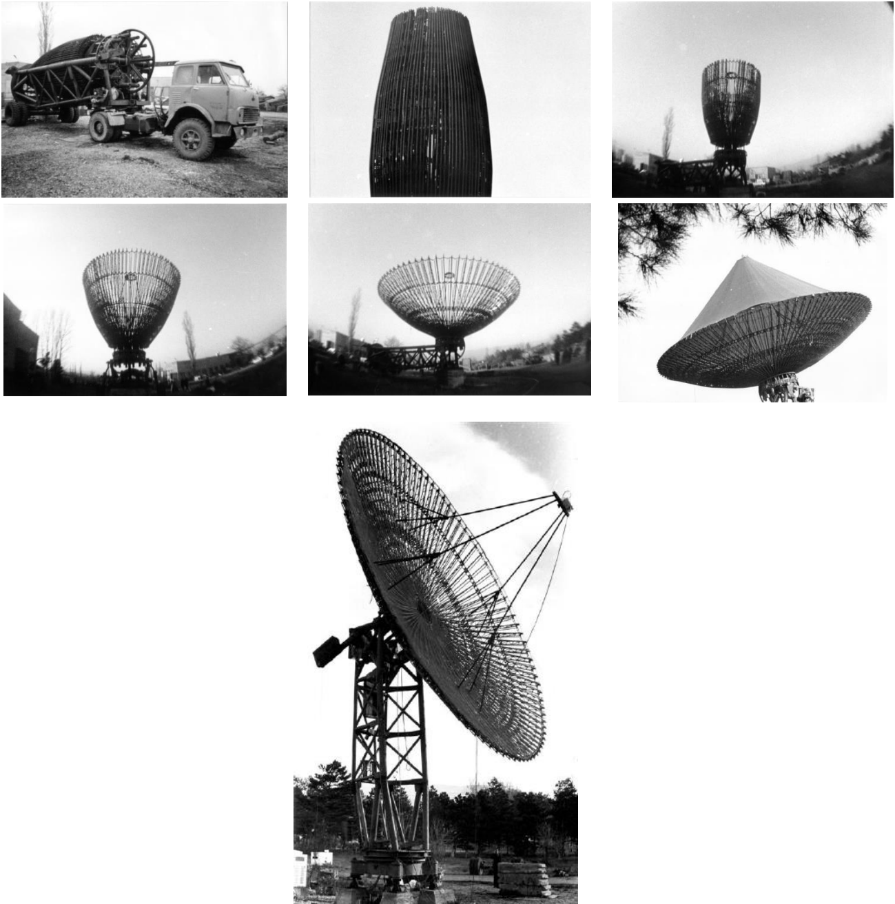
მრავალჯერადი გამოყენების, გასაშლელი სრულად მბრუნავი, მაღალი სიზუსტის მიწისზედა რეფლექტორული ანტენა დიამეტრით 12 მეტრი.
