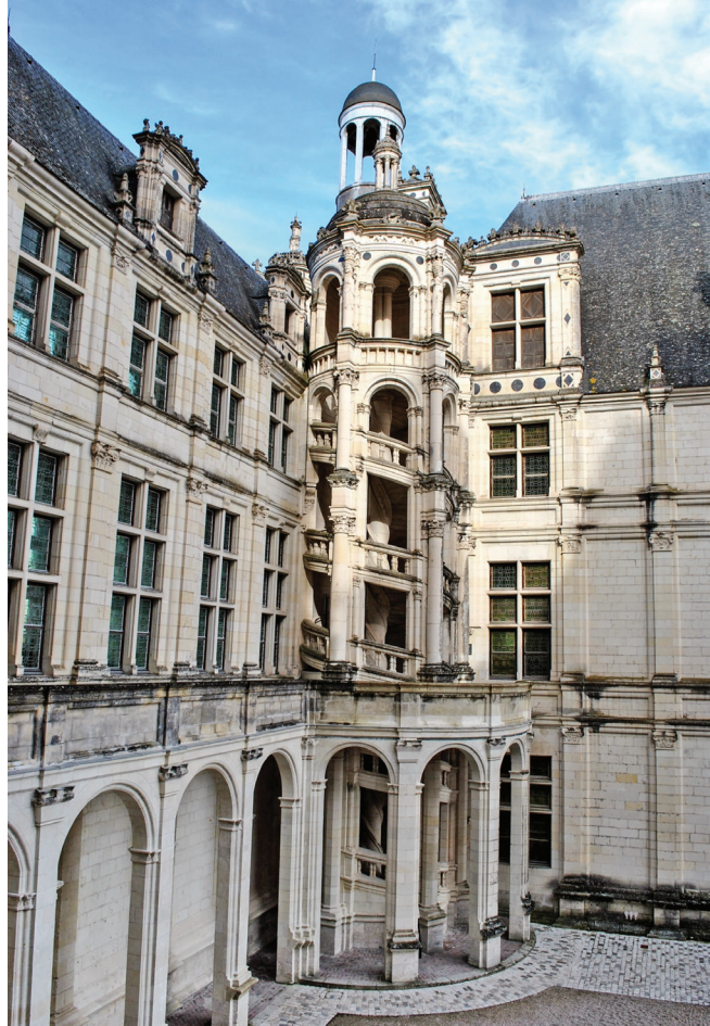
ორი შესასვლელის მქონე ორი სპირალური კიბე ისეა დახვეული, რომ ერთმანეთს არ კვეთს. (ზემოთ) კიბის კომპი, (შუაში) ორმაგი ხვეული კიბე, (ქვემოთ) კიბის კომპის ტურა
