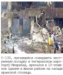
C-130, пытаясь совершить экстренную посадку в тегеранском аэропорту Мехрабад, врезался в 10-этажное здание в жилам районе на западе иранской столицы.
