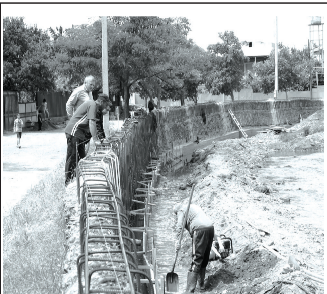
მდინარე სურამულას ნაპირსამაგრი სამუშაოები
