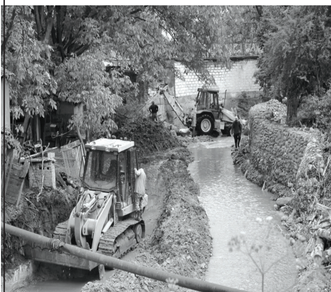
მდინარე ბიჯნისულას ნაპირსამაგრი სამუშაოები
