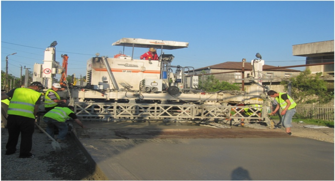
ნახ.20. მუშების განლაგება გზის მონაკვეთზე. მანქანები;მუშები თანრიგის მიხედვით; დამბეტონებლები.
