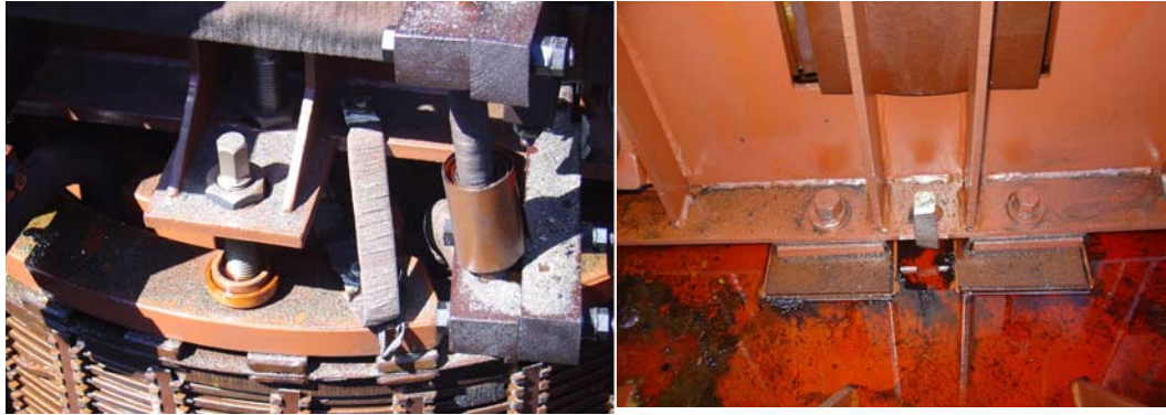
ნახ. 1.2. მყარი მინარევები ტრანსფორმატორის აქტიური ნაწილის ზედაპირზე
