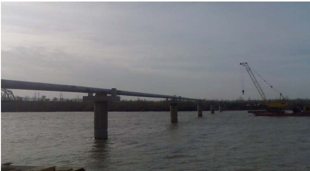
ფოტო №12, ა. საპაერო გადასასვლელის საერთო ხედი მდინარე რიონზე.
