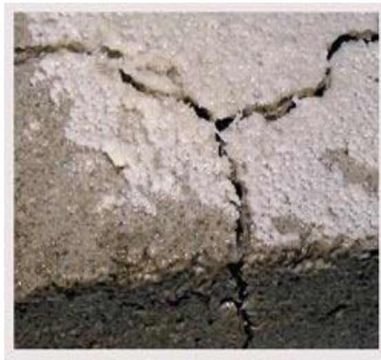
სურ.1.1. ბეტონის დაშლა ეტრინგიტის წარმოშობის შედეგად
