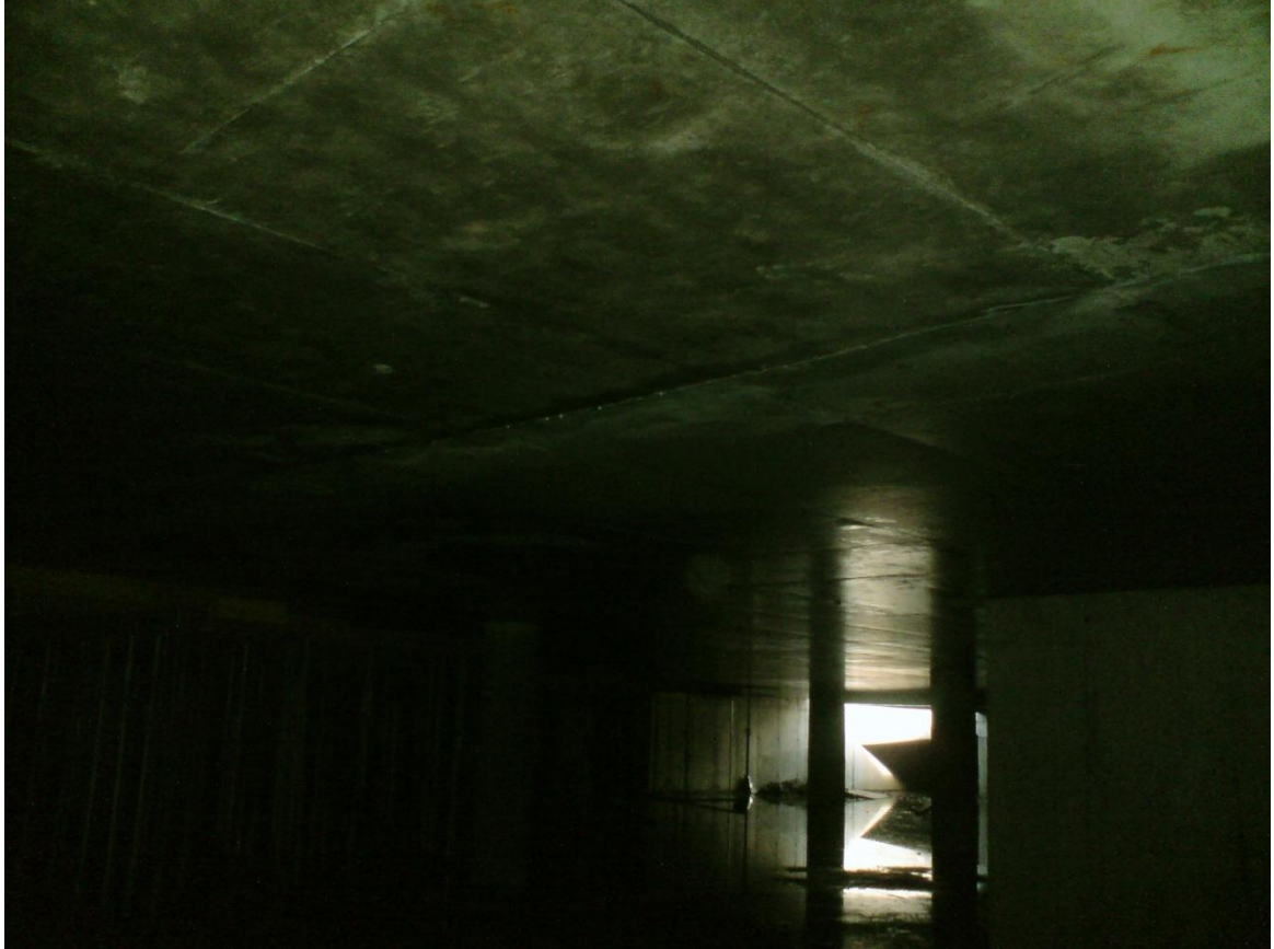
ნახ. 66 ბეტონის შეპირაპირების ზონა დაბეტონების შემდეგ. “პილტონის” სასტუმრო. ქ. ბათუმი. პროექტის სახელწოდება: ‘Black Sea Hotel & Residences’
