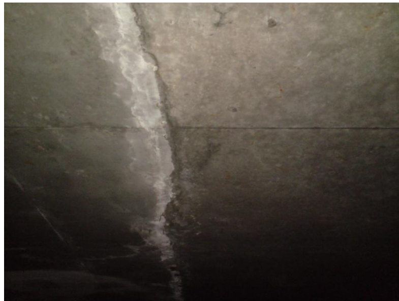
ნახ. 64 ბეტონის შეპირაპირების ზონა დაბეტონების შემდეგ. “ჰილტონის” სასტუმრო. ქ. ბათუმი. პროექტის სახელწოდება: ‘Black Sea Hotel & Residences’
