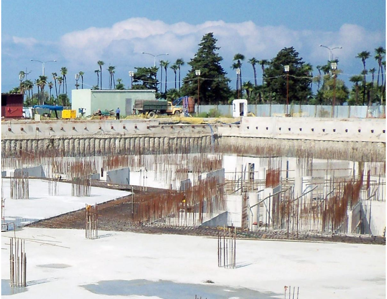
ნახ. 62 ბეტონის შეპირაპირების ზონა. “პილტონის” სასტუმრო. ქ. ბათუმი. პროექტის სახელწოდება: ‘Black Sea Hotel & Residences’
