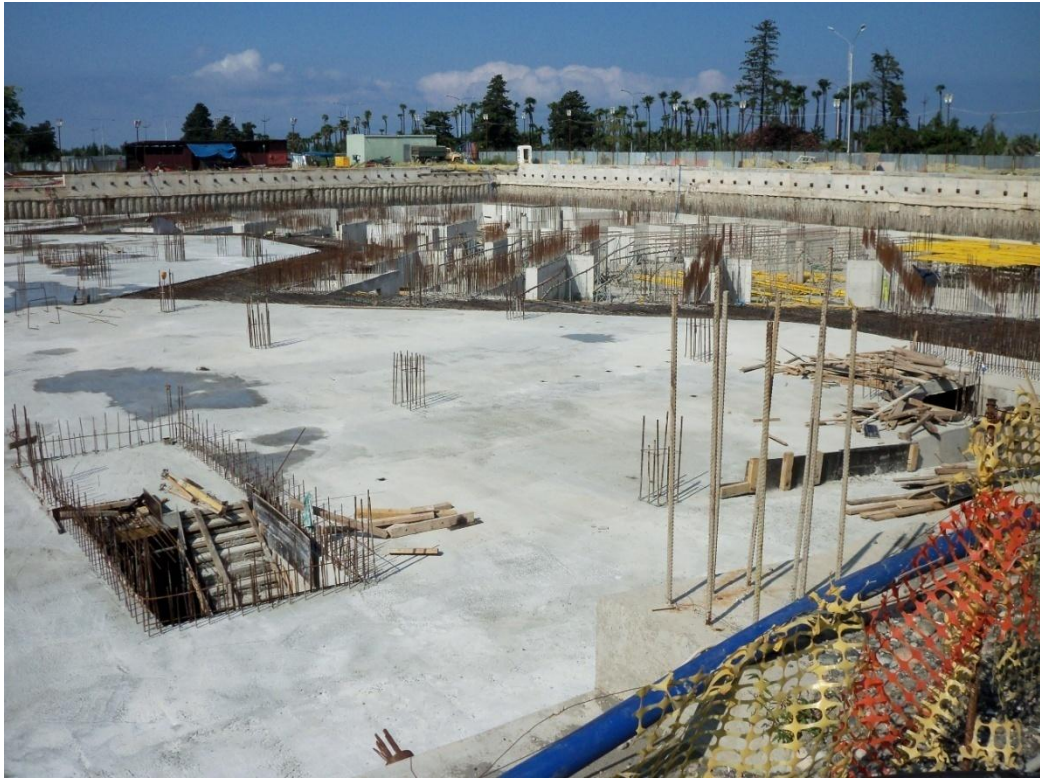
ნახ. 63 ბეტონის შეპირაპირების ზონა. “ჰილტონის” სასტუმრო. ქ. ბათუმი. პროექტის სახელწოდება: ‘Black Sea Hotel & Residences’
