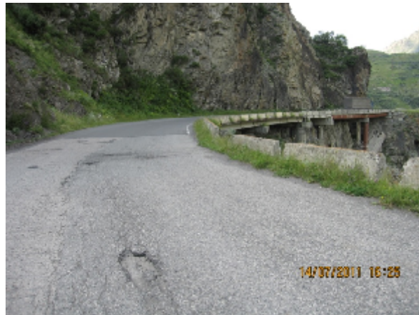
სურათი 5.1. ასფალტ-ბეტონის საფარის მდგომარეობა რემონტამდე
