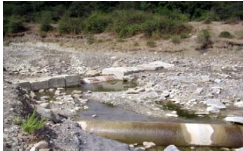
ნახ. 43. მაგისტრალური გაზსადენების რამოდენიმე ავარიული უბნის ხედები
