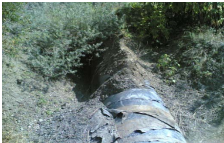
ნახ. 43. მაგისტრალური გაზსადენების რამოდენიმე ავარიული უბნის ხედები
