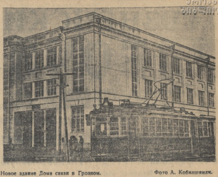
Новое здание Дома связи в Грозном. Фото А. Кобашкина.
