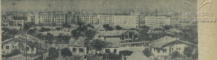
В посёлке имени Степана Разина (г. Баку), где во Октябрьской революции происходила именная оккупация, сейчас выросли огромные корпуса учебных и жилых комбинатов. НА СНИМКЕ: новый жилищный комбинат на 200 квартир для рабочих - нефтяников. При комбинате имеется баня, ремонтные мастерские и пр. Фотошпана ТАСС.
