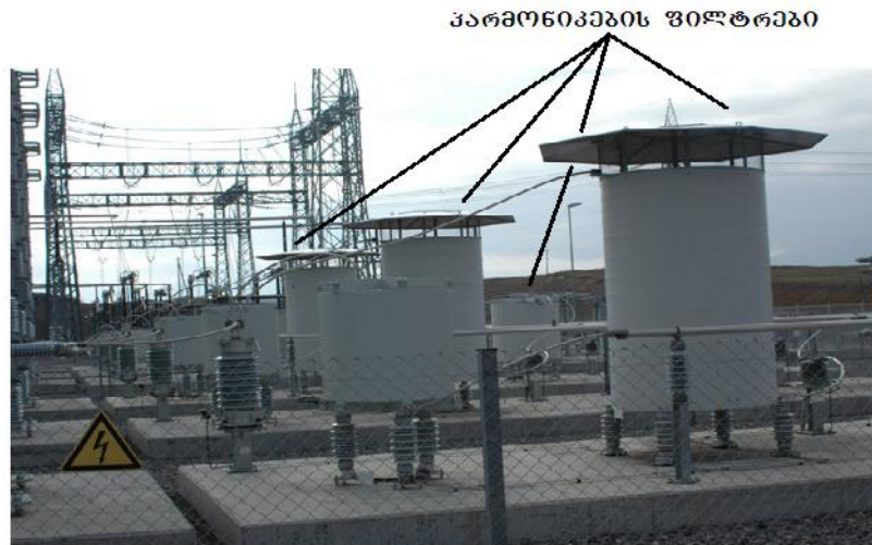
ნახ.4.7. ახალციხის 500/400 კვ ძაბვის ქვესადგურში განთავსებული ფილტრების საერთო ხედი
