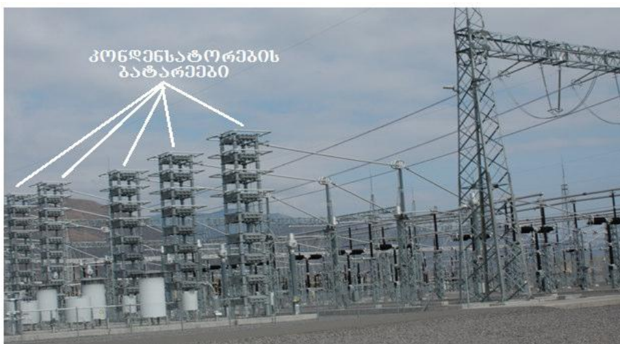
ნახ.4.8. ახალციხის 500/400 კვ ძაბვის ქვესადგურში განთავსებული კონდენსატორების ბატარეის საერთო ხედი
