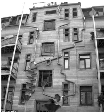
Около этой поющей стены собираются туристы в дождливую погоду, чтобы послушать, в буквальном смысле, музыку дождя. Сложная система отвода дождевых вод, состоящая из замысловатых комбинаций труб и воронок различных форм, размеров и конфигураций закреплена на фасаде дома.
