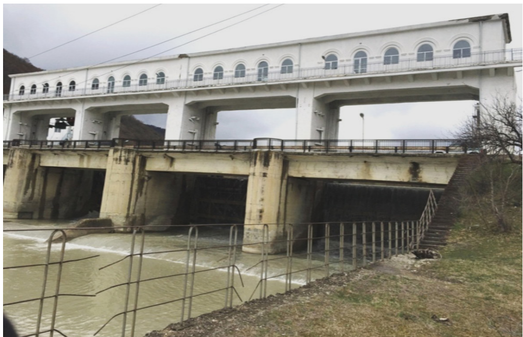
სურ. 6.3. მდ. იორზე სათავე ნაგებობა (საგარეჯოს რაიონი, სოფ. პალღო) ა) სათავე კვანძის ზედა ბიეფი; ბ) სათავე კვანძის ქვედა ბიეფი
