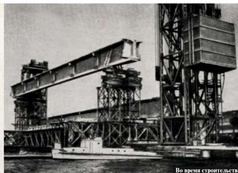
Во время строительства
