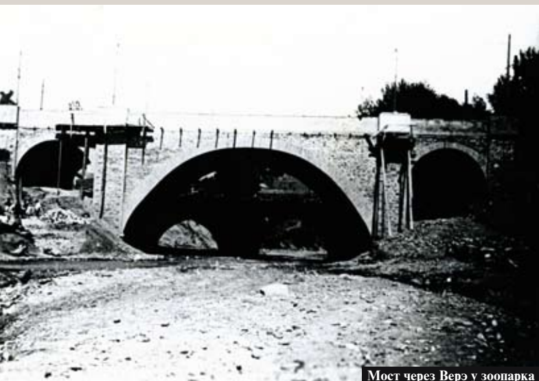
Мост через Верз у зоопарка
