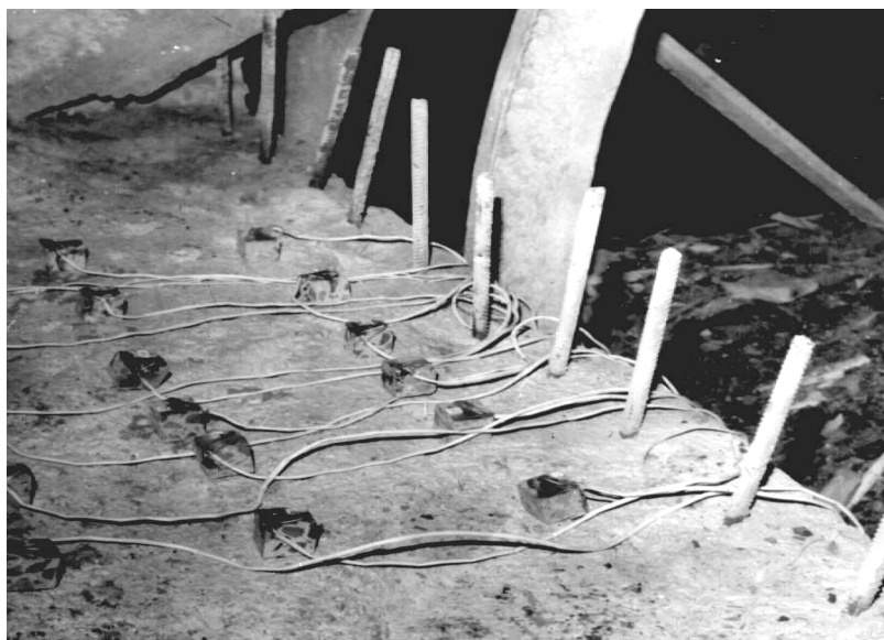
Рис. 2. 11. Процесс установки динамометров ТД-1 в монолитной обделке
