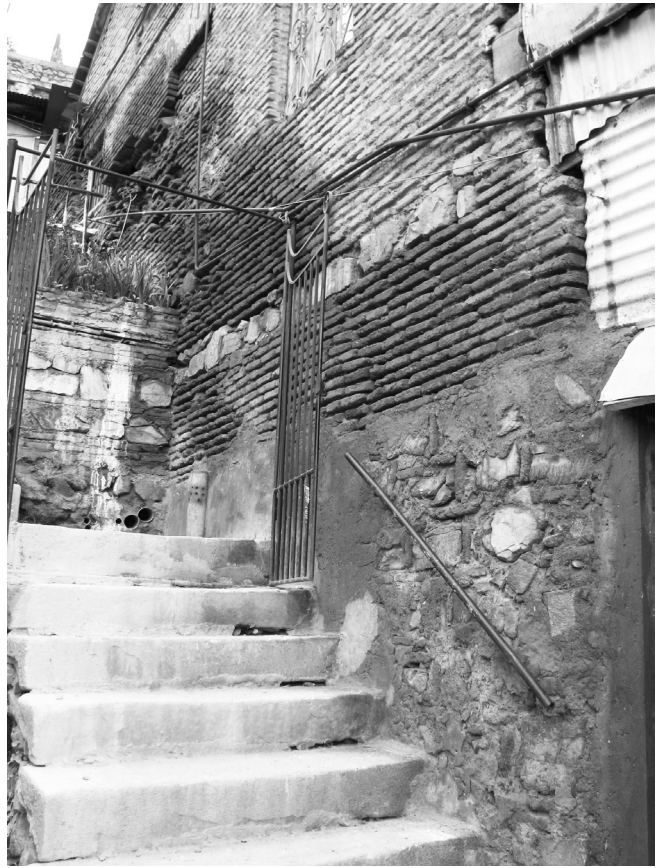
3. გომის III ჩიხის №11. სხვადასხვა დროის შრეები გვერდითი კედლის წყობაში Different period layers discernable in masonry of the side wall. 11, Gomi Blind Alley III
