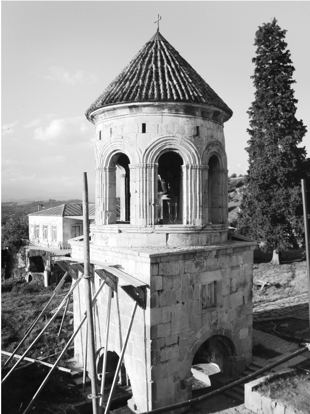
7. მოჭიქული კრამიტი გელათის მონასტრის სამრეკლოს სახურავზე Glazed Tiles on the Roof of the Gelati Monastery Bell Tower
