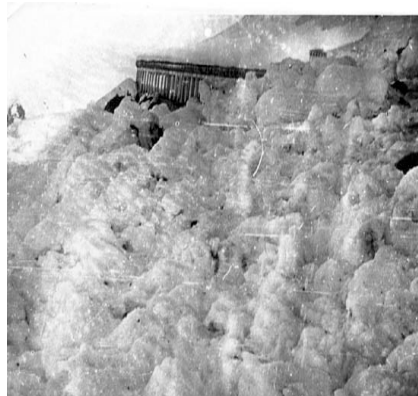
ნახ. 4. ზვავსაწინააღმდეგო გალერვა საქართველოს სამხედრო გზაზე
