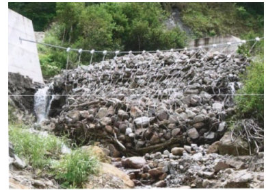
სურ. 25. ელასტიური ღვარცოფსაწინააღმდეგო ბარაჟი მუშაობისას, შვეიცარია
