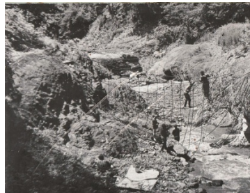
სურ. 24. ელასტიური ღვარცოფსაწინააღმდეგო ბარაჟი მდ. ღურუჯხე
