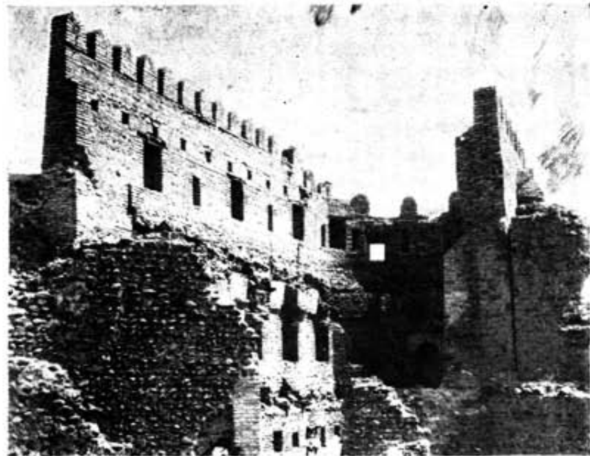
1 Ксани. Интерьер входной башни
