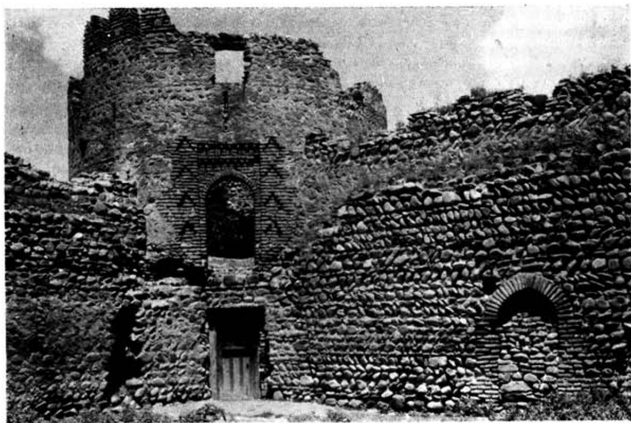
2 Мухрани. Вид северо-восточной башни со двора
