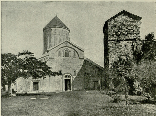
Общий вид с севера. Вид с запада на храм и башню.
