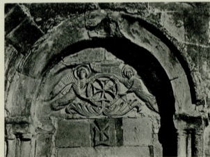
Рельеф вознесения креста над главным входом с юга.
