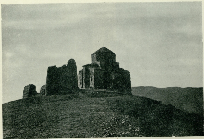
Общий вид с севера.
