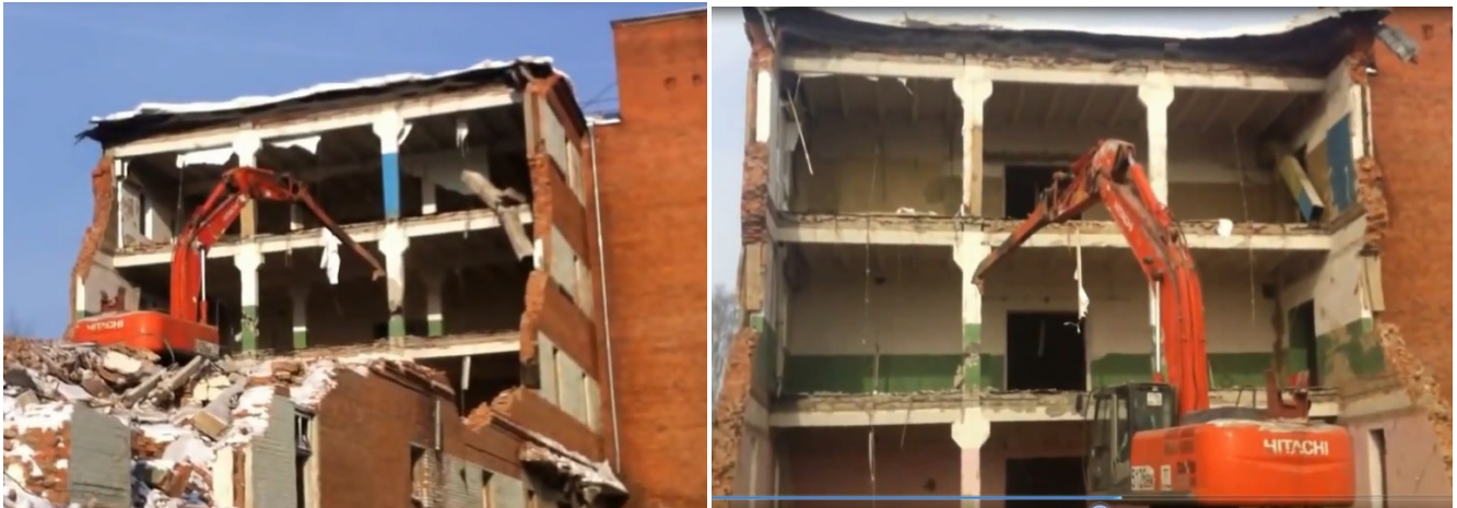
ნახ. 5. სანგრევი უროს („კოდალა“) გამოყენება ვერტიკალური კონსტრუქციების დასაშლელად (დასანგრევად)
