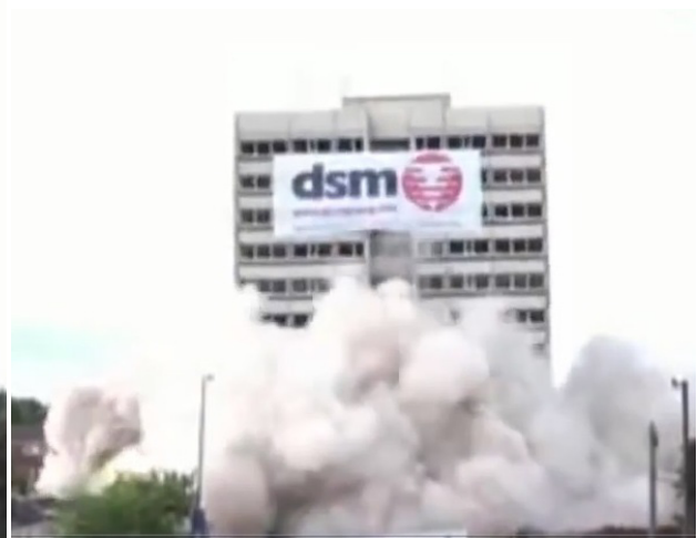
ფოტო 6. შენობების აღება აფეთქებით (შენობის ჩამონგრევა სრულდება ვერტიკალურად ფუძეზე): ა – აფეთქებამდე; ბ – აფეთქების შემდეგ
