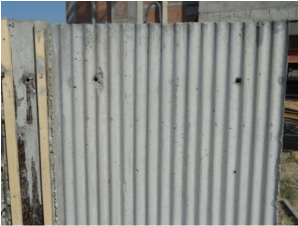
ფოტო 7. დაბეტონებული რთულპროფილურ ზედაპირიანი შრე ვერტიკალური ტალღოვანი ღარობებით
