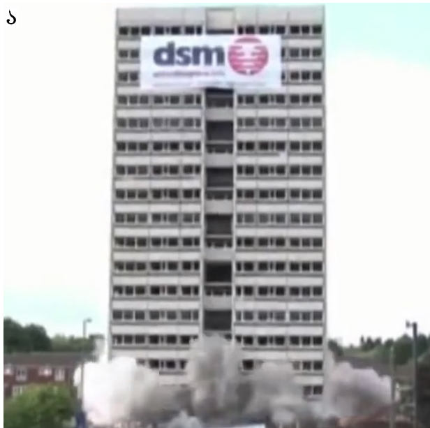
ფოტო 6. შენობების აღება აფეთქებით (შენობის ჩამონგრევა სრულდება ვერტიკალურად ფუძეზე): ა – აფეთქებამდე; ბ – აფეთქების შემდეგ
