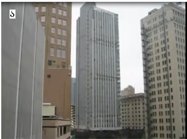
ფოტო 7. შენობების აღება აფეთქებით (შენობის ჩამონგრევა ხორციელდება განსაზღვრული მიმართულებით, არსებულ შენობებს შორის): ა – აფეთქებამდე; ბ – აფეთქების შემდეგ
