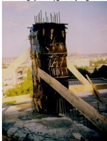
ფოტო 4. დაკვირვებები ბეტონის ტემპერატურულ დინამიკაზე შავი პოლიეთილენის აფსკით დაფარულ კონსტრუქციაზე
