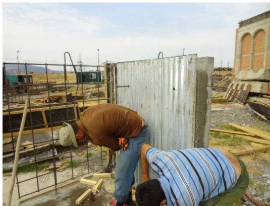
ფოტო 8. დაბეტონებული 2-შრიანი კედელი შრეების ჰორიზონტალურ ღარობებიანი მიმხრობით. მიმდინარეობს შიდა საყალიბე ფარის დემონტაჟი
