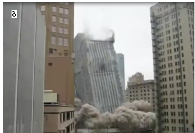
ფოტო 7. შენობების აღება აფეთქებით (შენობის ჩამონგრევა ხორციელდება განსაზღვრული მიმართულებით, არსებულ შენობებს შორის): ა – აფეთქებამდე; ბ – აფეთქების შემდეგ
