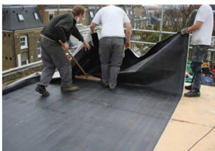
ფოტო 15. პოლიმერული ჰიდროსაიზოლაციო მემბრანის მოწყობა სინთეტიკურ ფუძეზე
