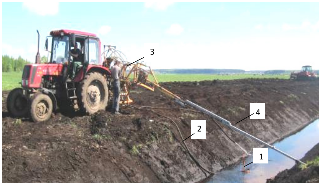
Рис. 3. Промывка дренажных коллекторов установкой УПД-120 с применением направляющего устройства УНТ-6 конструкции РУП «Институт мелиорации»: 1 – заборное устройство ЗУ-2; 2 – заборный шланг; 3 – дренопромывочная машина; 4 – направляющее устройство УНТ-6.
