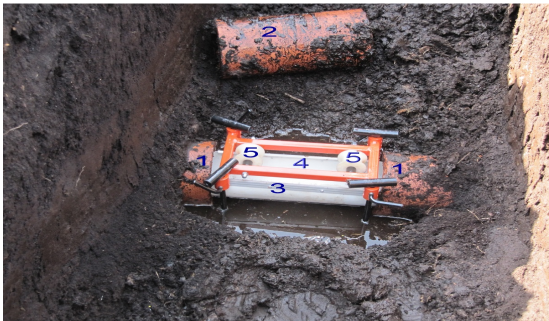
Рис. 2. Установка муфты промывочной МПГ-1:
