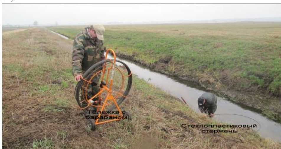
Рис. 1. Оценка внутреннего состояния устьевой и прилегающей частей дренажного коллектора с помощью ОД-100.
