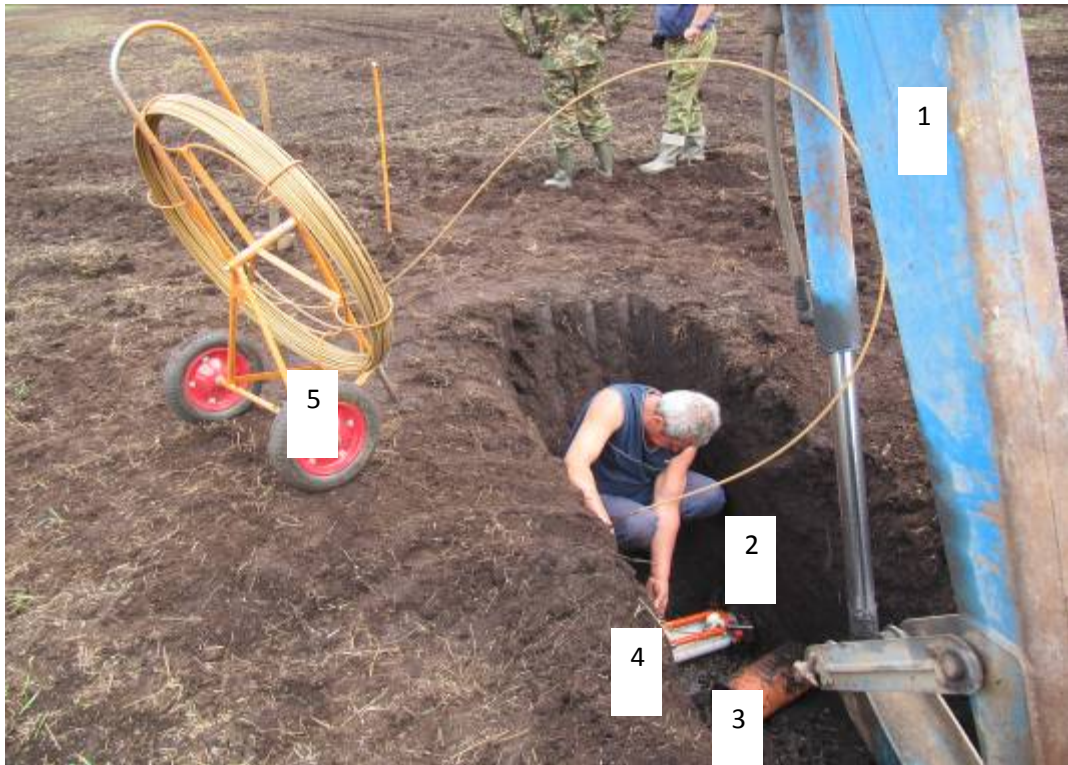
Рис. 2. Оценка состояния внутренней полости дренажного коллектора с помощью устройства ОД-100 и промывочной муфты МПГ-1: 1 – стрела экскаватора; 2 – шурф; 3 – извлеченная трубка дренажного коллектора; 4 – промывочная муфта МПГ-1, присоединенная к дренажному коллектору на месте извлеченной дренажной трубки; 5 – устройство ОД-100.
