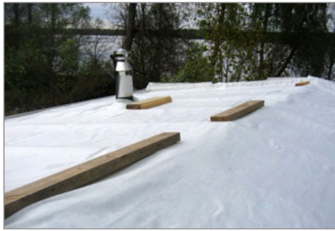
ფოტო 12. ბურულზე მოწყობილი ფესვდამცავი აფსკი
