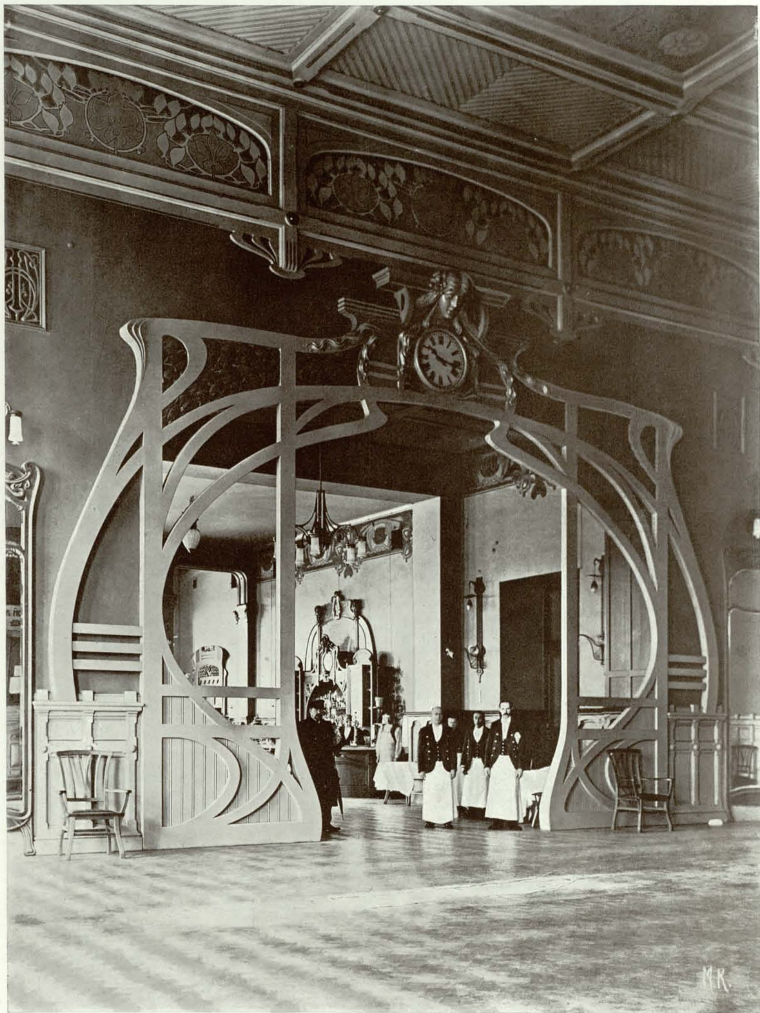
ПАСАЖИРСКОЕ ЗДАНИЕ Ст. С.-ПЕТЕРБУРГЪ. Видъ изъ зала I класса на ресторанъ.
