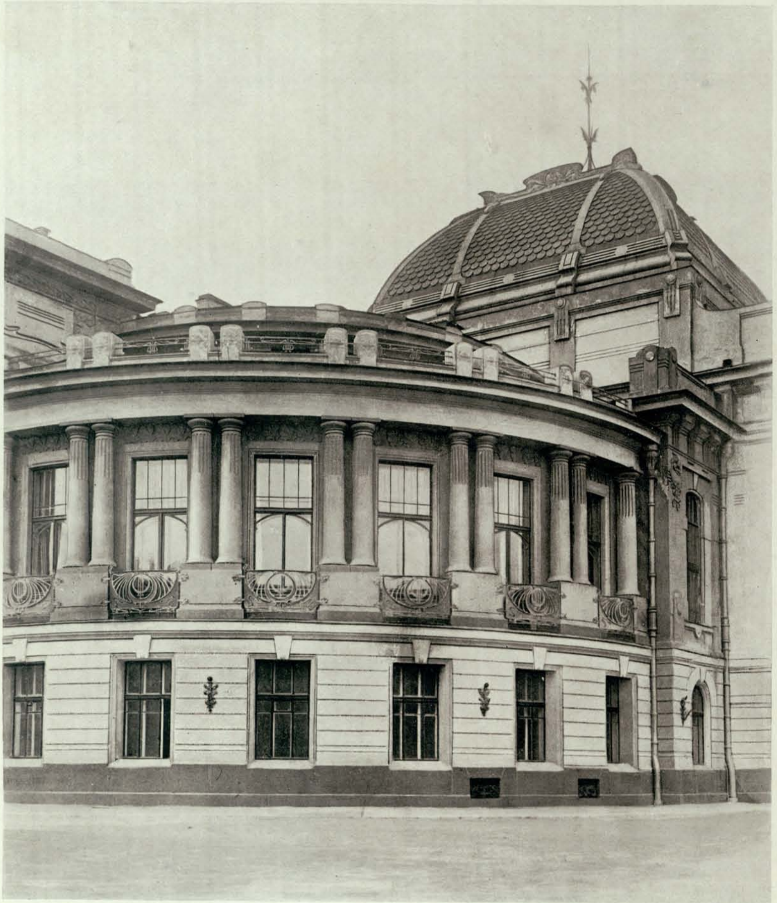
ПАСАЖИРСКОЕ ЗДАНИЕ Ст. С.-ПЕТЕРБУРГЪ. Закругленіе фасада.
