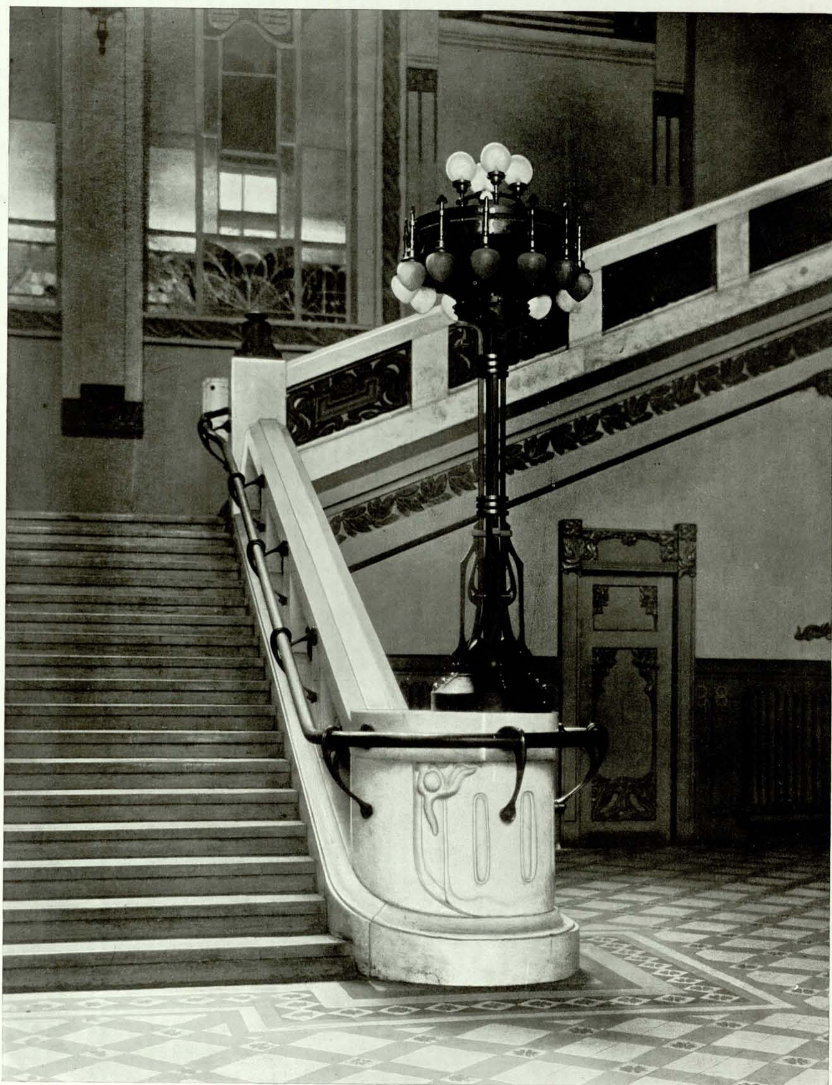
ПАСАЖИРСКОЕ ЗДАНИЕ Ст. С.-ПЕТЕРБУРГЪ. Деталь лѣстницы вестибюля.
