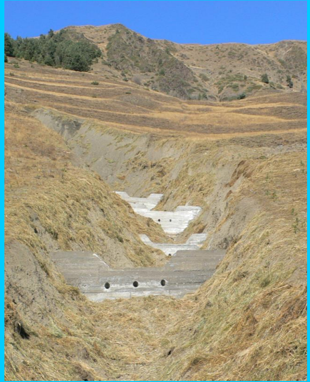
ეროზიულ-ღვარცოფული პროცესების საწინააღმდეგო ბარაჟები სოფელ ჯვარბოსელში (მთათუშეთი, ახმეტის რაიონი). სამუშაო განხორციელდა მსოფლიო ბანკის დაფინანსებით. პროექტის ხელმძღვანელი, პროფესორი გივი გავარდაშვილი
